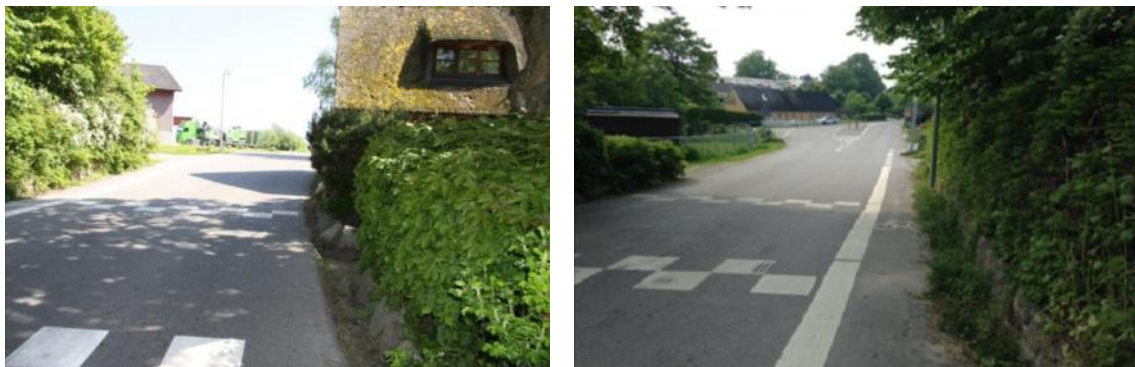
Figur 12. det smalle vejprofil og cirkelbump ud for hus nr. 5
